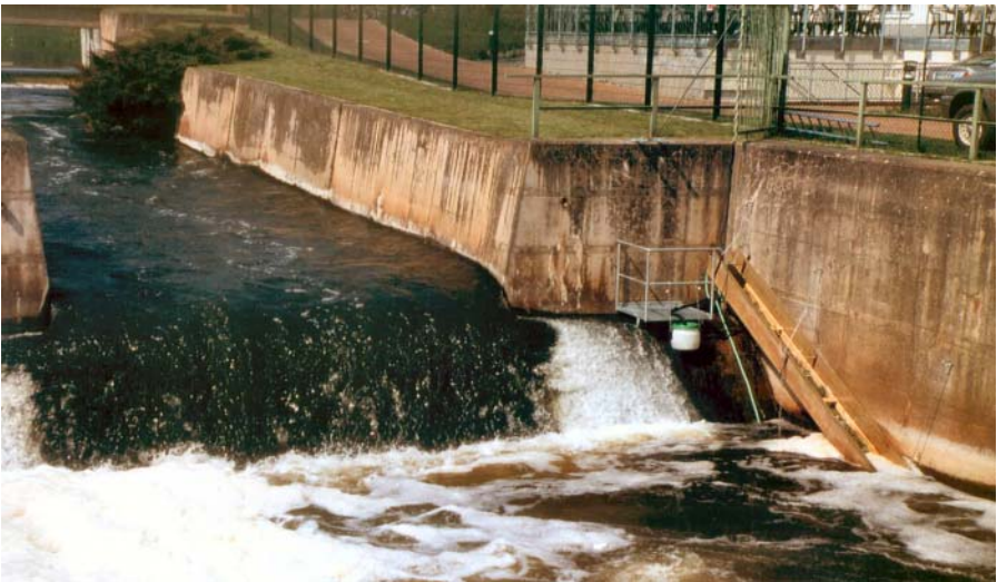
Abb. 2: Fest installierte Rinne in der Uecker am Wehr Torgelow
