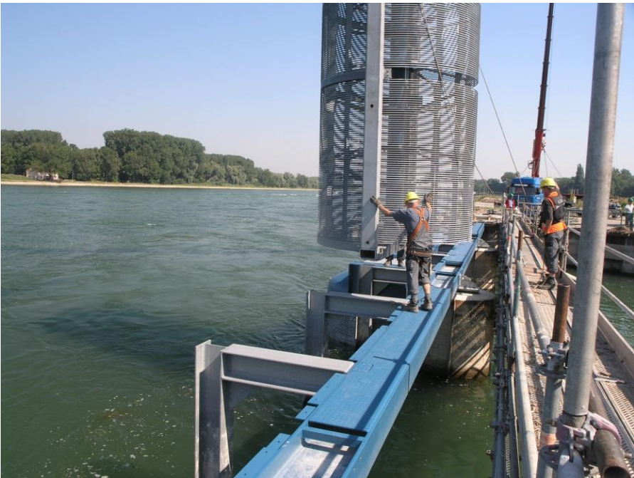
Abb. 1: Einbau der rotierenden Fischschutzzechen vor dem Entnahmebauwerk des Rheindampfkraftwerks Karlsruhe (2012)
