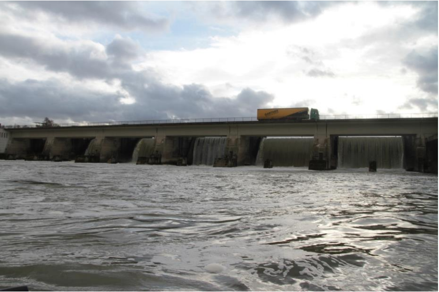
Abb. 3: Wehrfeld der Rheinstaustufe Iffezheim
